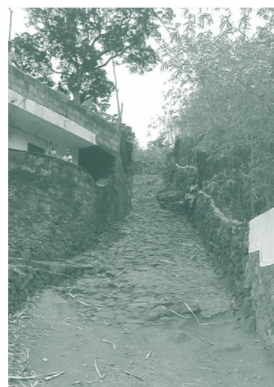
Camiño antes de ser rehabilitado
