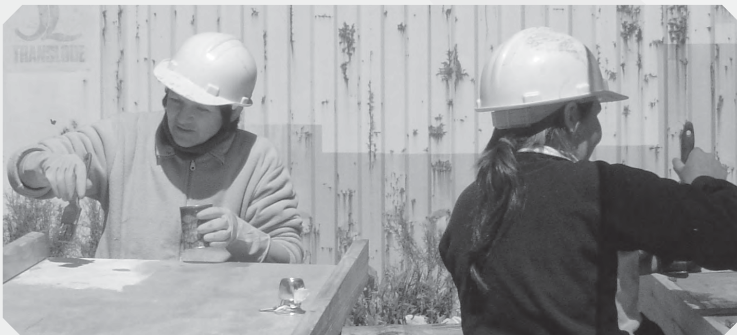
Traballo na obra de construción de La Vereda
